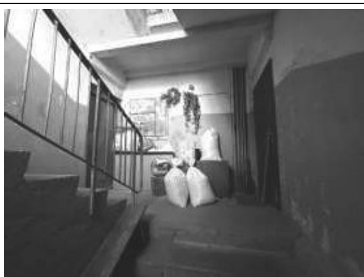
1.stāva kāpņu telpa
